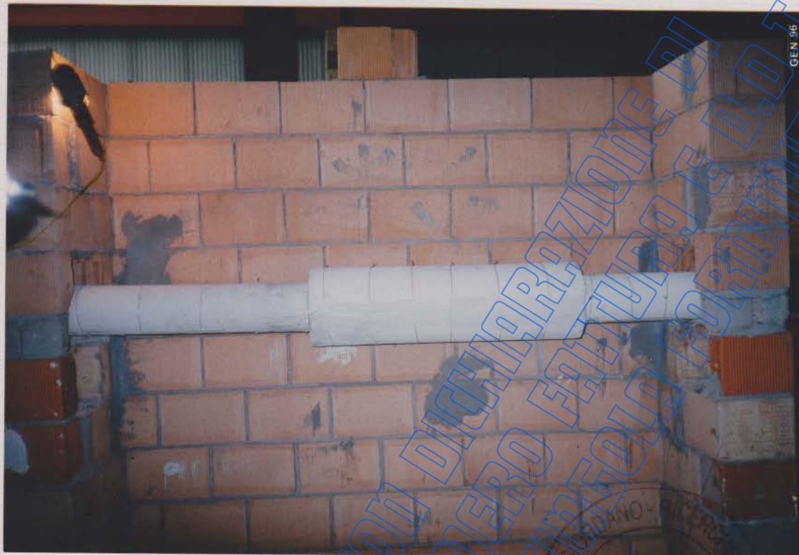
Foto 3 : Fotografia del campione durante la fase di allestimento della prova.
