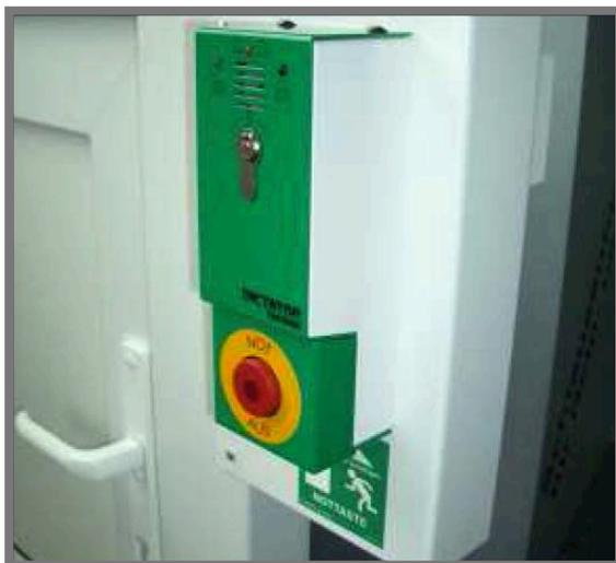
Il sistema blocco porta **DS DICTATOR TVS** è studiato per l'installazione su singole porte. E' un sistema "**Stand Alone**" per singole porte già dotato di alimentatore integrato. Si può montare facilmente anche su porte già in opera. Il sistema **TVS** viene utilizzato principalmente per il controllo di uscite d'emergenza e per il controllo accessi.
